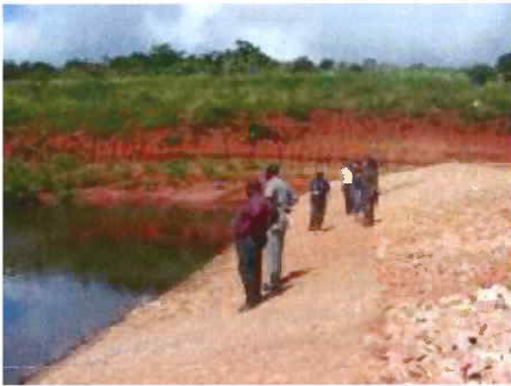
Bezirksbeamten besichtigen den Kisanga Damm, der mit Hilfe von Plan gebaut wurde.
