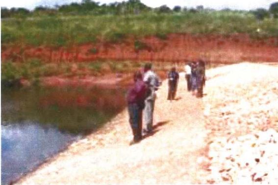
Bezirksbeamte besichtigen den Kisanga-Damm, der mit Hilfe von Plan gebaut wurde.
